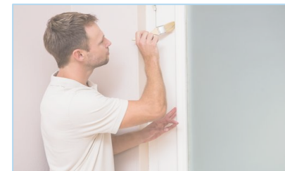
PETITS TRAVAUX DE PEINTURE
